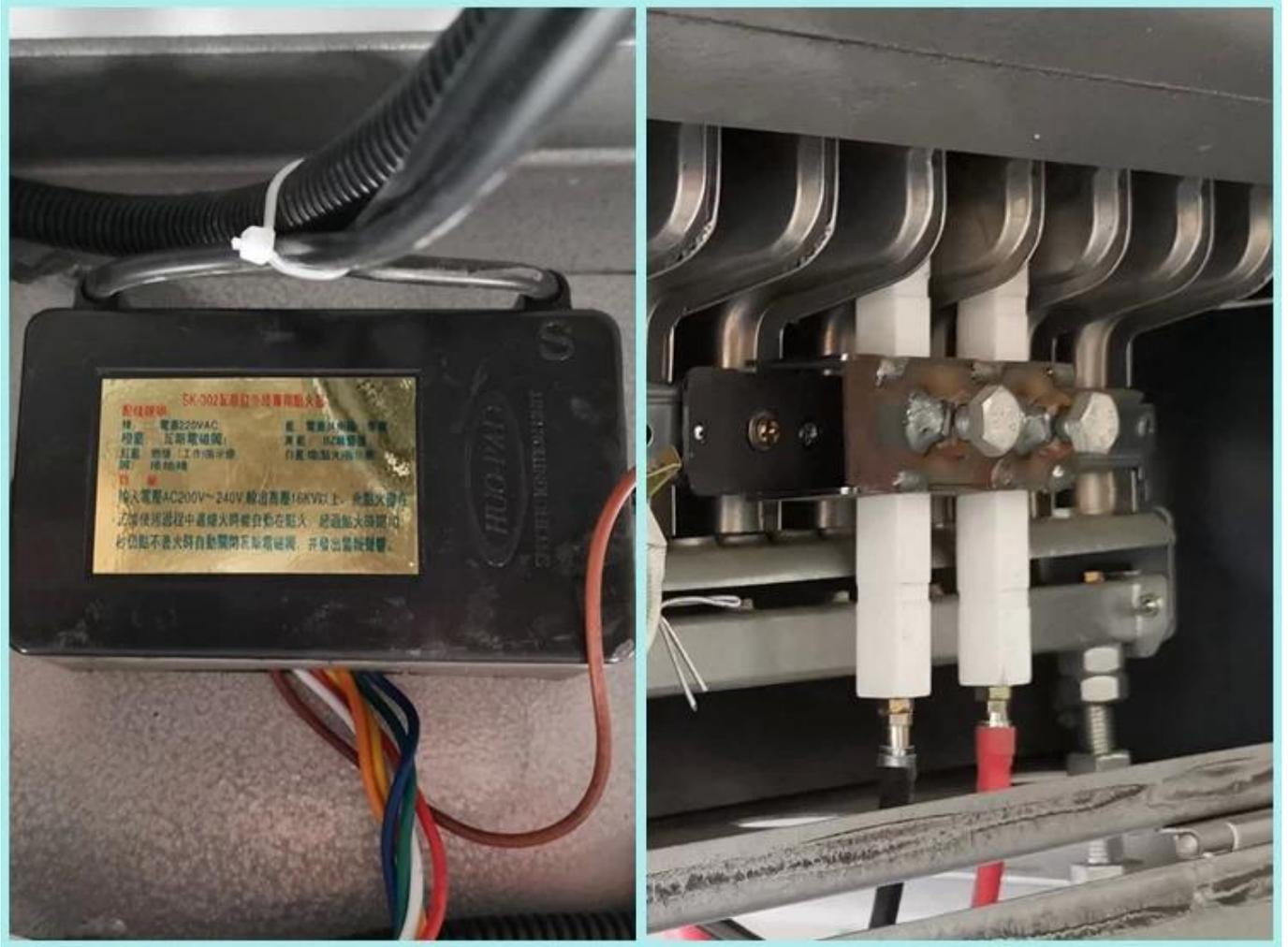
Las agujas de doble encendido y las bobinas de encendido completamente automáticas garantizan un encendido 100% exitoso y sin desperdicio de combustible.
